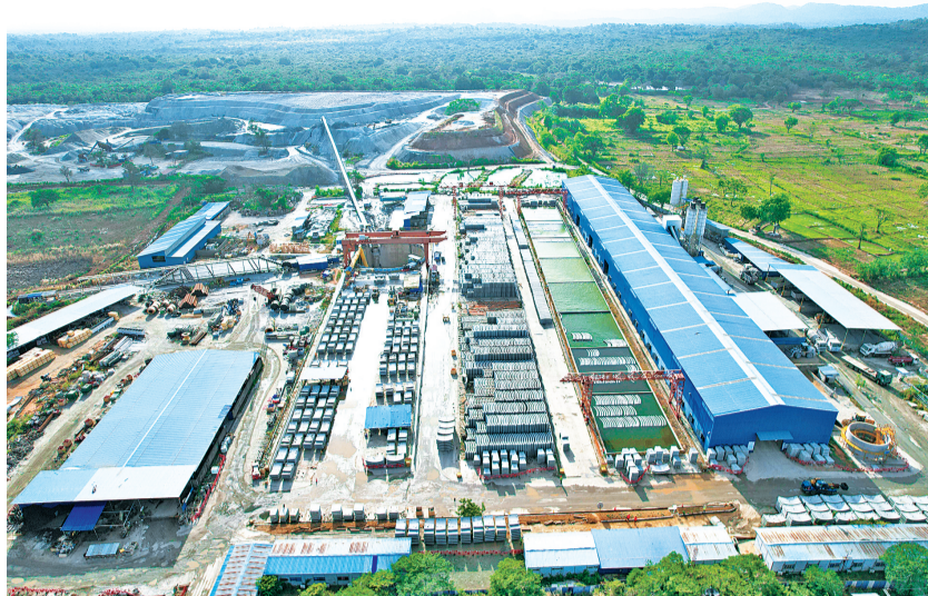
这是2026年1月19日拍摄的斯里兰卡埃勒黑勒运河引水隧洞项目施工现场(无人机照片)。(新华社发 中国建筑股份有限公司项目组供图)
