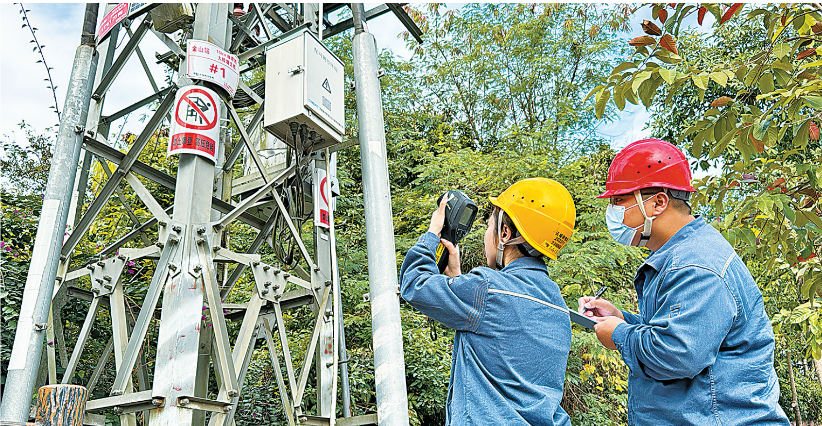
巡检人员利用红外测温仪对设备测温
