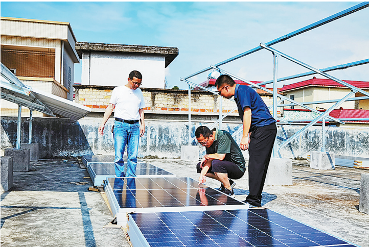
悦塘村光伏项目施工现场
