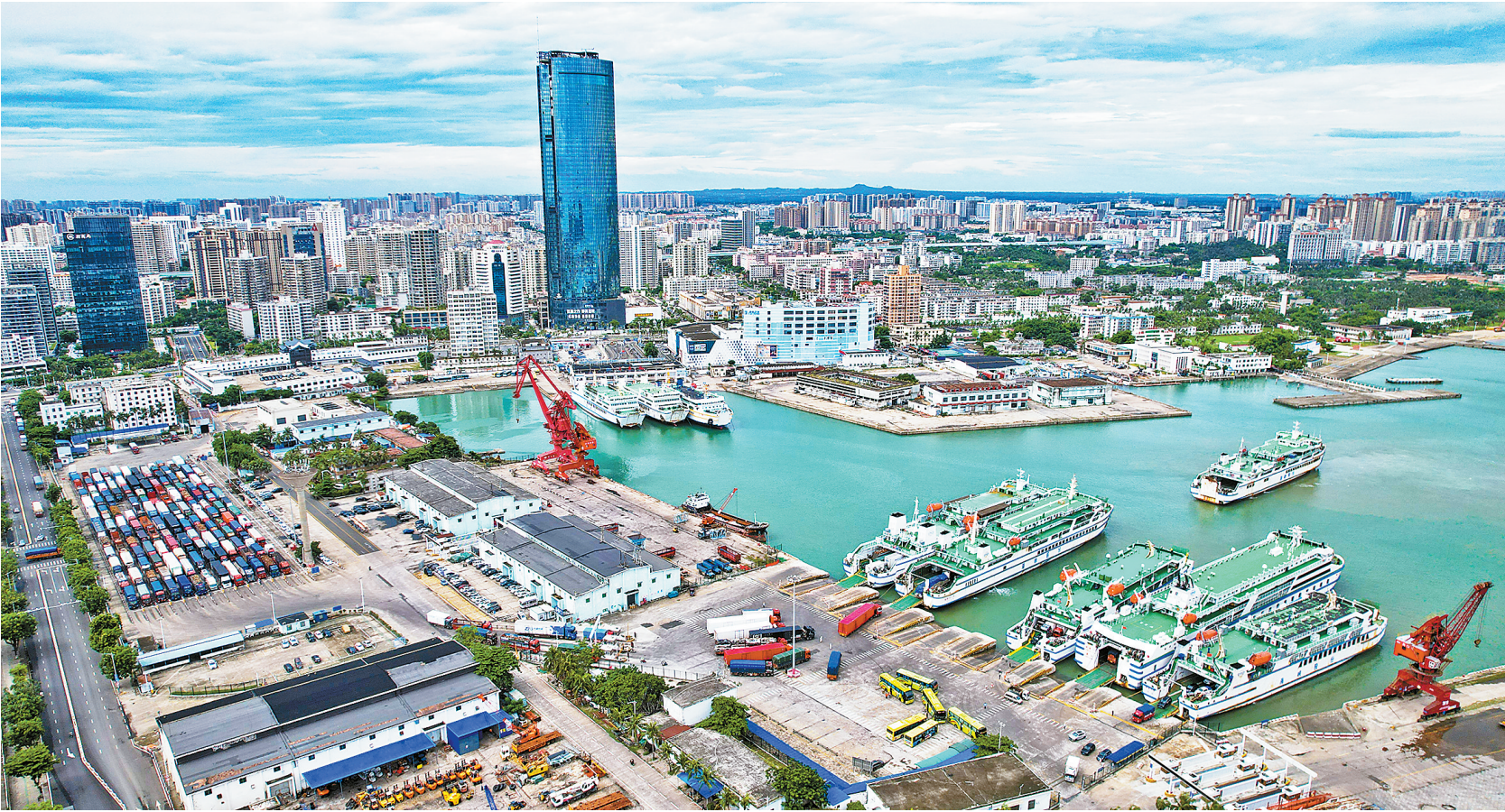
这是7月22日拍摄的恢复通航后的海口市秀英港。7月22日上午,随着今年第6号台风“韦帕”影响逐渐减弱,琼州海峡客滚船运输有序恢复。(新华社记者 杨冠宇 摄)
