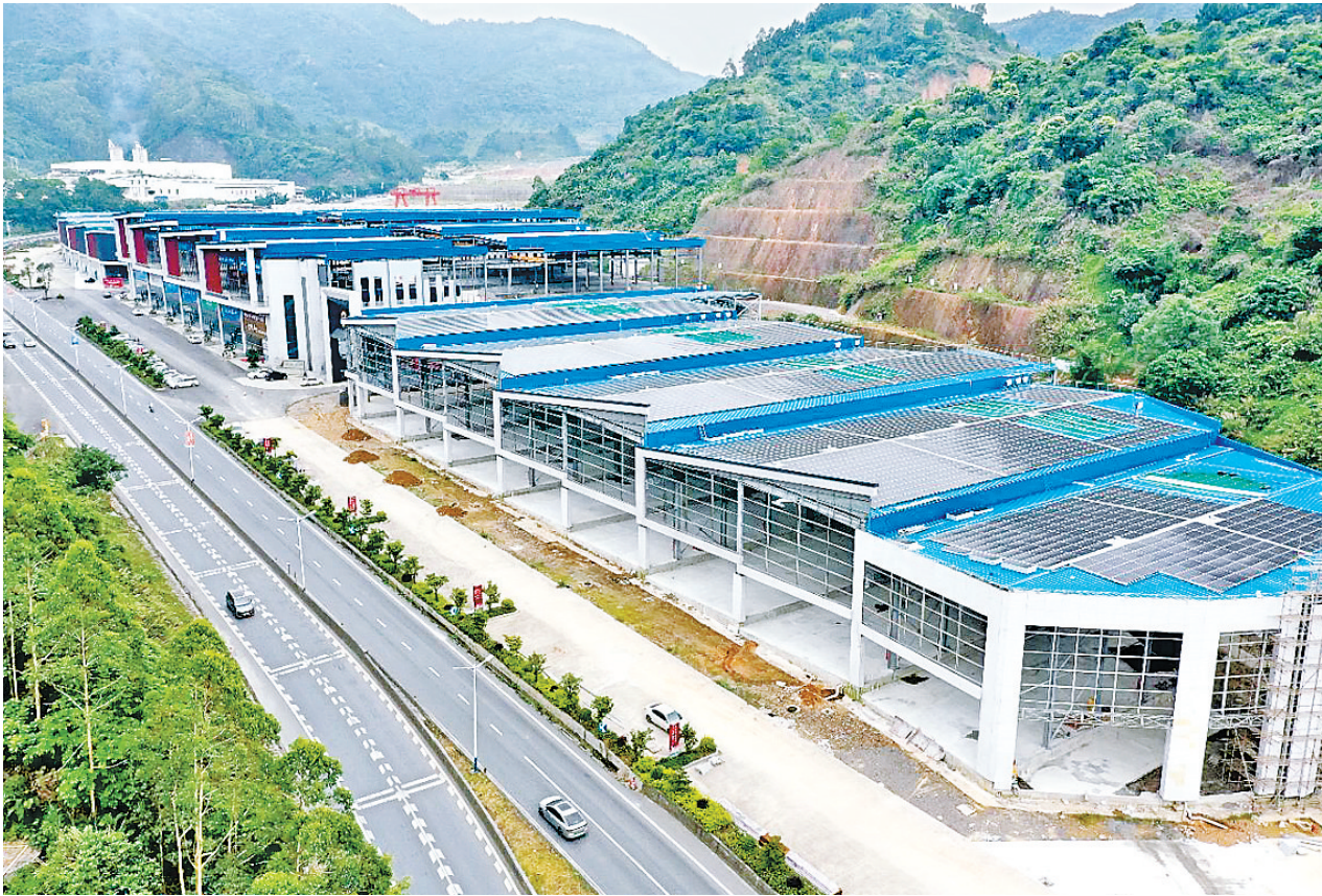
中云石海石材智造产业园
