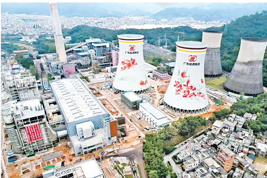
云河发电公司天然气热电联产项目建设外景
