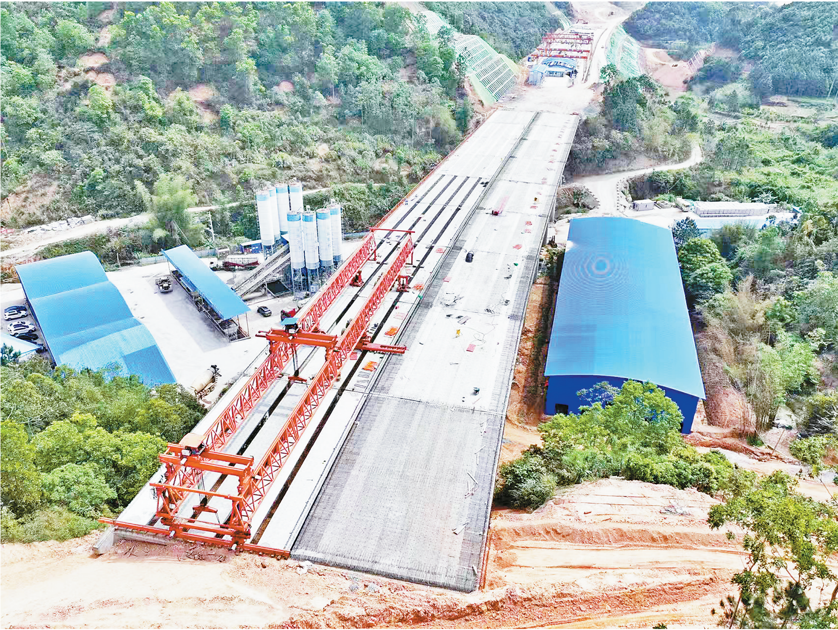
国道324线云浮段改线工程(市交通运输局供图)
