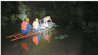
南方电网广东云浮云安供电局在西江洪水过境期间排受水浸的设备。
