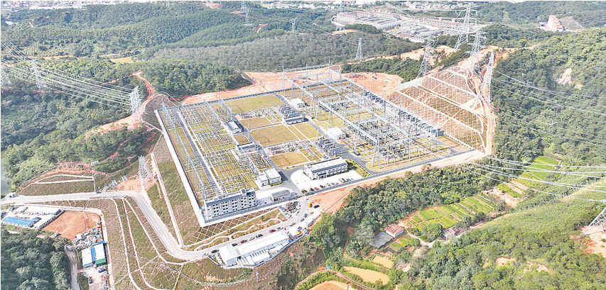
500千伏立安变电站
