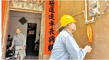
南方电网广东云浮云安供电局六都供电所为独居老人更换开关。
