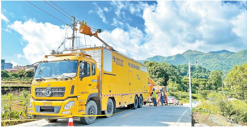
南方电网广东云浮罗定供电局迺纶供电所供电人员顶着烈日对10千伏沙底开展设备消缺工作。
