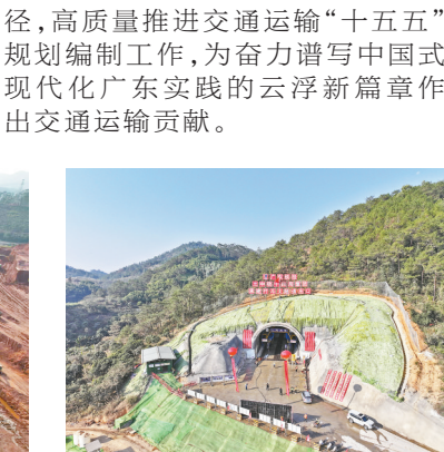
深南高铁云浮段首座隧道竹斗夫隧道于2024年12月底顺利贯通
