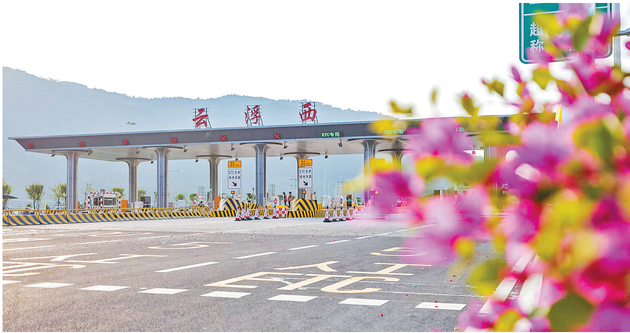
云(浮)梧(州)高速云浮西互通立交项目正式建成通车
