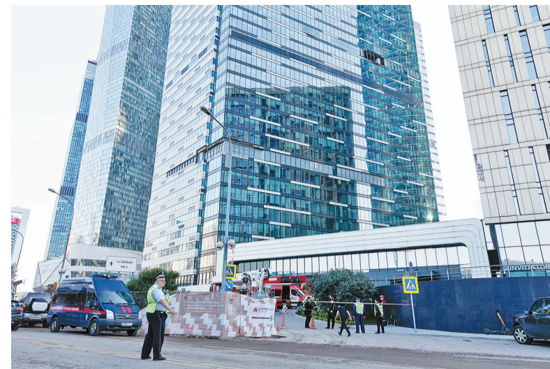
8月1日在俄罗斯首都莫斯科拍摄的受损建筑。(新华社记者 白雪琪 摄)
