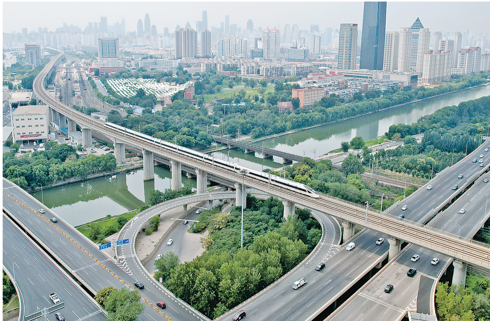
天津城际列车从天津城区穿行(7月20日摄,无人机照片)。
