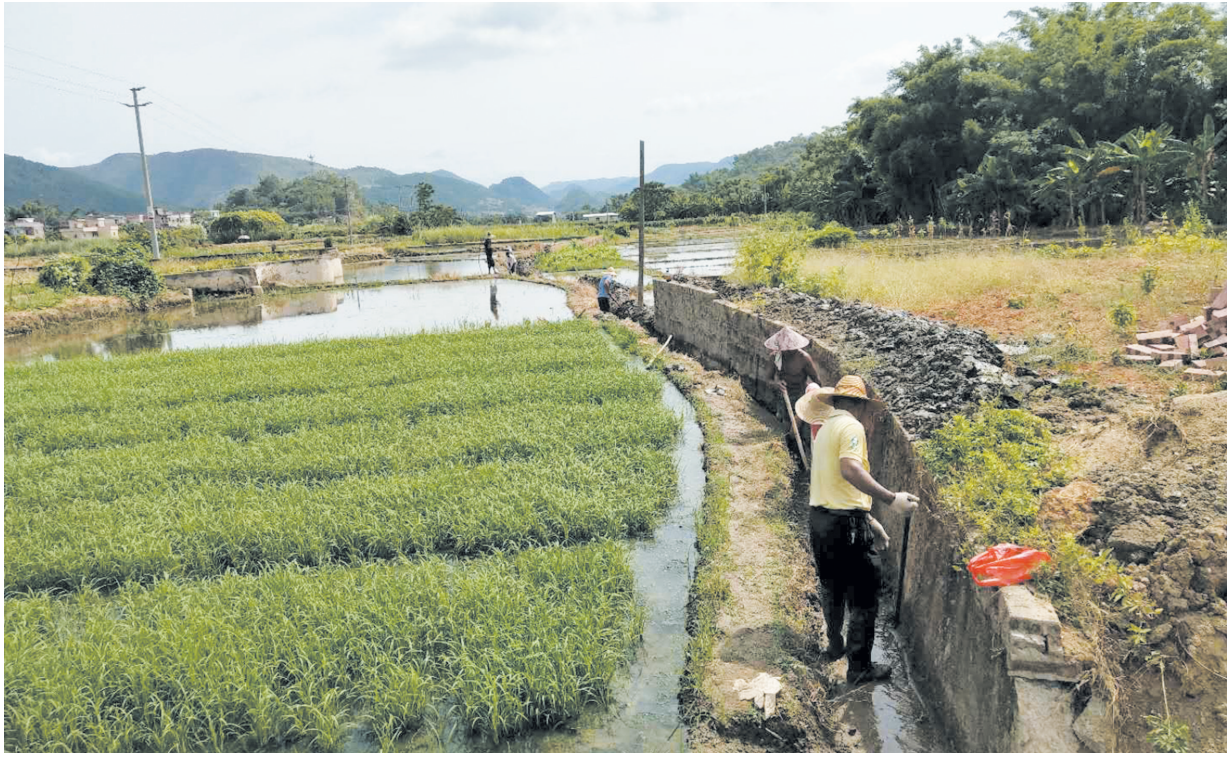
修复灌溉水渠
