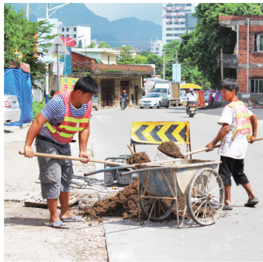
工作人员冒着酷暑紧张施工
