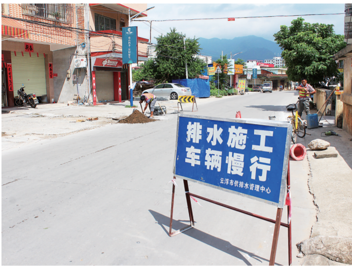
道路两边竖起了施工警示牌
